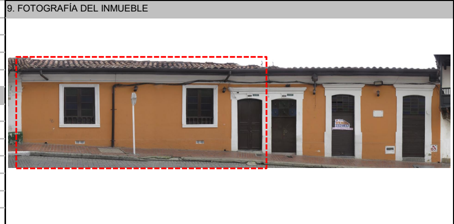
Fuente: Equipo Fotografía PEMP Patrimonio Inmueble
